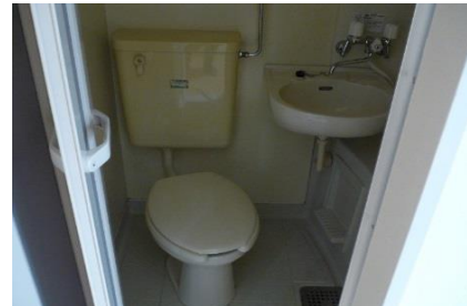
●トイレと浴室
